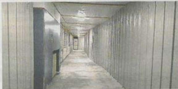
Il tunnel ricavato al piano interrato dell'ospedale per il passaggio in sicurezza dei pazienti Covid19
